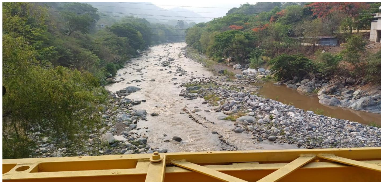
Anexo 26. Punto de monitoreo Puente Bailey.
