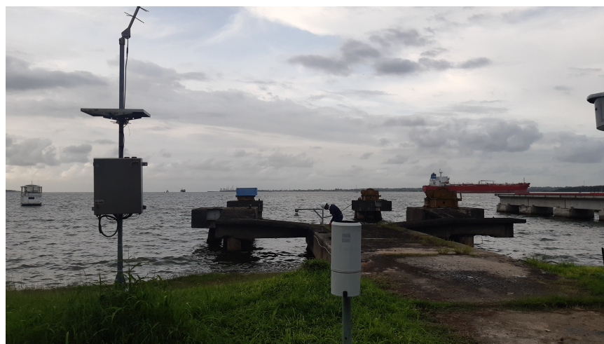
Figura 6.2: Estación mareográfica ubicada en el Comando Naval del Caribe ubicada en Santo Tomás de Castilla, Puerto Barrios Izabal
