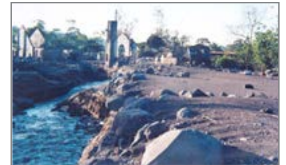
Vista de la iglesia del viejo Palmar, población destruida por lahares (correntadas de lodo y escombros de origen volcánico en el río Nimá II, en 1984)
